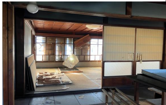
2階和室12から南を見る
