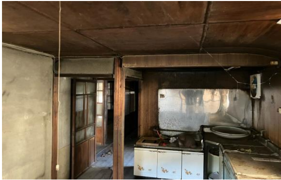
台所から北を見る
