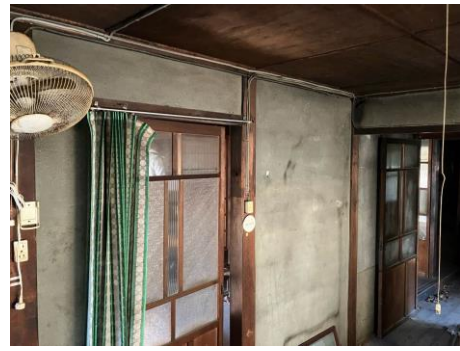
<内壁>土壁（40mm 程度）
