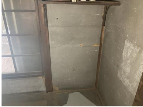
<外壁>土壁（40mm 程度）
