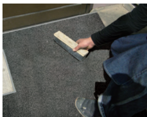
透水性アスファルト
