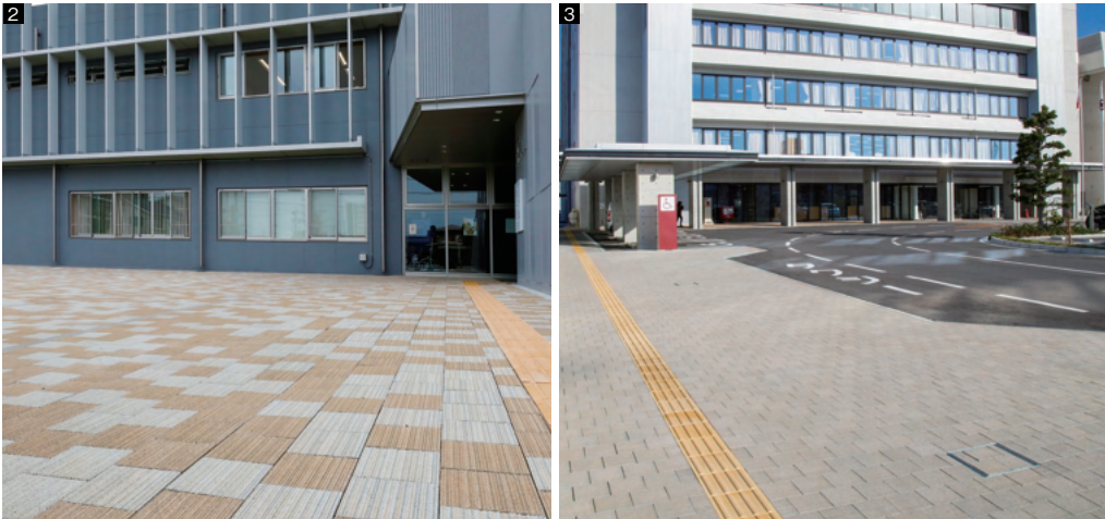
1 3 瀬戸市庁舎(愛知県瀬戸市)／レーヌブラウン 2 いちのみや中央プラザ体育館(愛知県一宮市)／レーヌグレー、レーヌベージュ、レーヌブラウン
