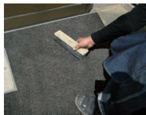
透水性アスファルト
